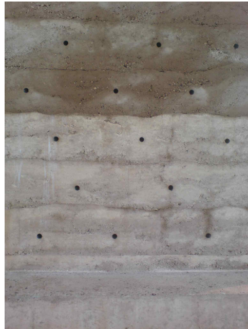
[그림 4-74] 오각 콘크리트 기둥 표면
