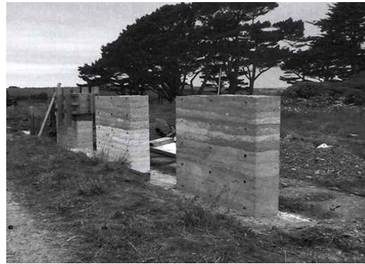
[그림 4-16] Chivelstone House, 2008 : 콘크리트 타설 방법에 따른 감각 경험의 변화
