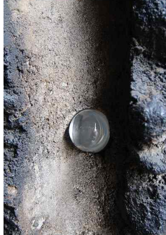
[그림 4-78] 파이프에 설치된 볼록 렌즈(내부)
