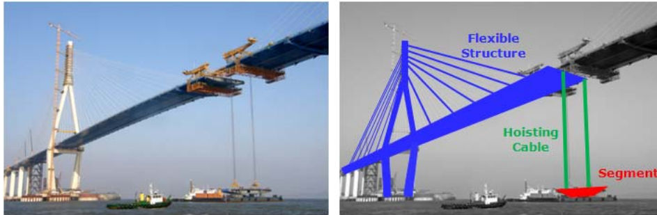
그림 4 FCM 공법을 이용한 세그먼트 인양
