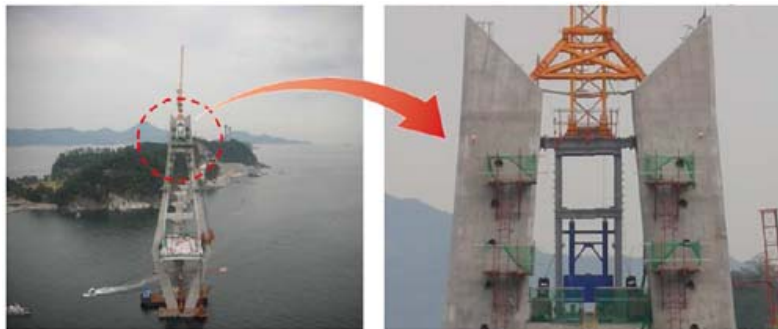
그림 3 사장교 가설시 진자형 TMD를 이용한 내풍 안정화 공법(대우건설)
