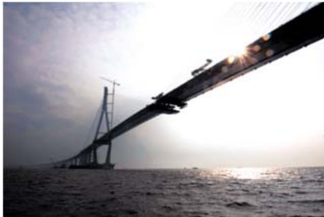
그림 12 최종 Key segment 연결 전 인천대교 시공 현장
