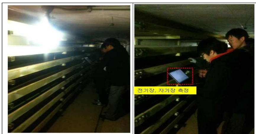
[그림 4-3 ] 김포국제공항 공동구 전력선통신 유기율 측정
