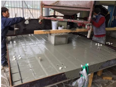
(e) UHPC pouring
