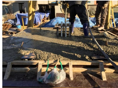
(d) Concrete pouring
