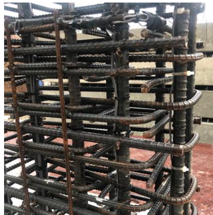
(b) U-tie module and U-end tie
