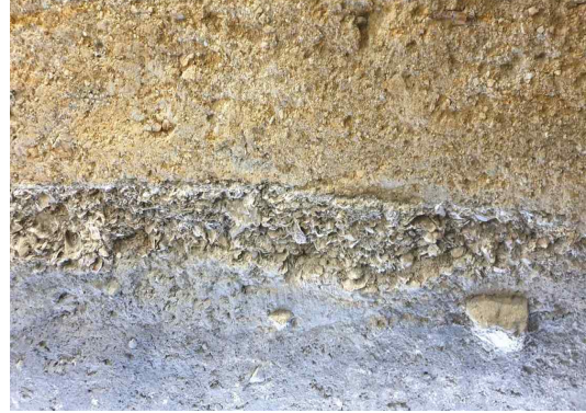
<그림 15> 울산 약사동 제방의 패각층(울산 약사동 제방 전시관, 2019.12.2 1. 본인 촬영)
