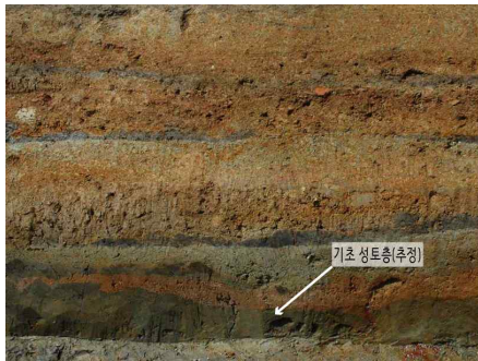
<그림 76> 상주 공검지 초축 제방 단면 토층(경상북도문화재연구원 2013: 53)
