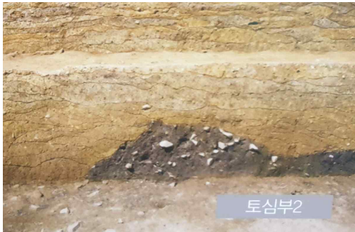
<그림 61> 울산 약사동 제방 심 조성(울산 약사동 제방 전시관, 2019.12. 21. 본인 촬영)
