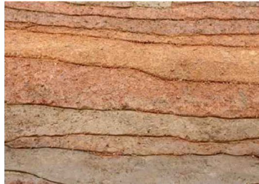
<그림 27> 김제 벽골제 1 Tr. 동벽 교호성토(전북문화재연구원 2015: 63 사진 50)
