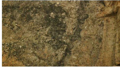
<그림 62> 울산 약사동 제방 초분류의 부엽층(약사동제방유적전시관 2017: 30)
