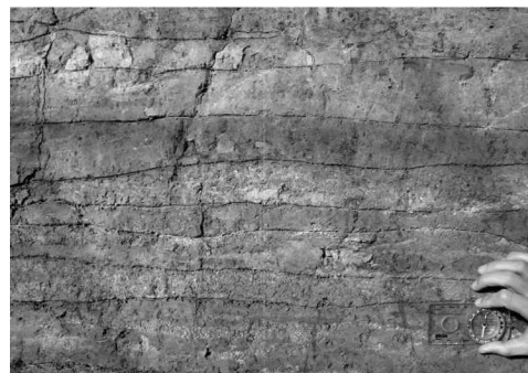
<그림 32> 김제 벽골제 N1E2 Gr. 보축 제방의 북쪽 단면 세부(전북 문화재연구원 2017a: 91 사진 92)
