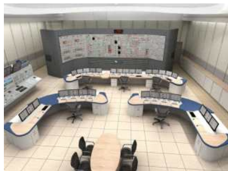
그림 5-11. 원전 APR1400 주제어실 평면도 및 전경 사진 (출처: https://aris.iaea.org/ , https://nucleus.iaea.org/ )
