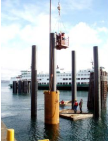
그림 2. 소음 저감 장치(cofferdam)
