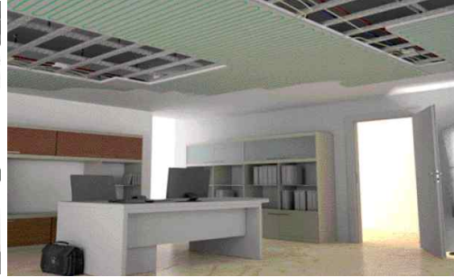
(b) 석고보드형 천장 복사 패널
