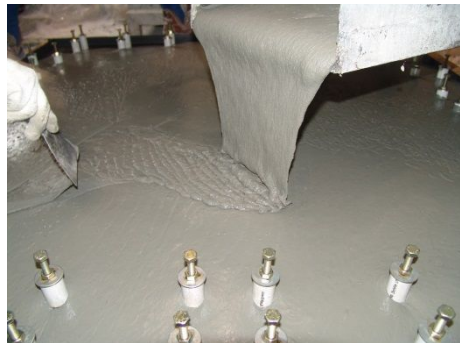
(e) Pouring UHPC
