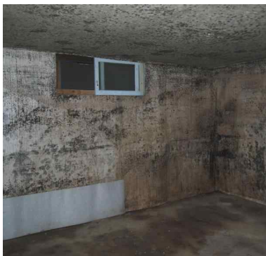
<그림3-4> 작은 개구부와 환기 부족으로 인한 악화된 실내 환경
