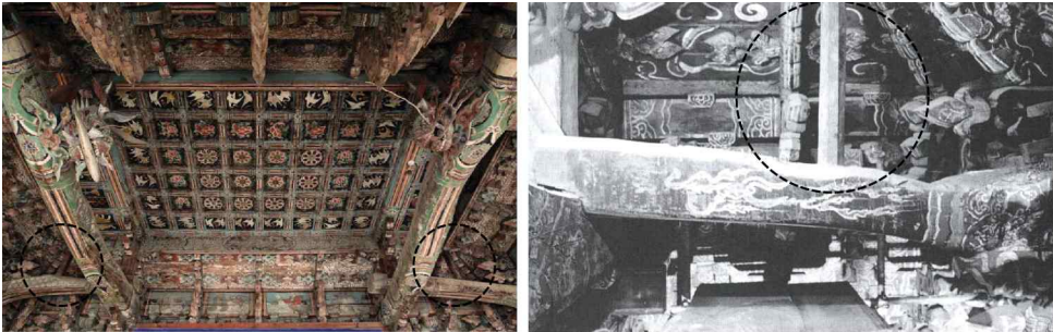
그림 4-35. 세장한 막대를 사용한 층랑 상부의 수직부재 (좌: 내소사 대웅보전, 우: 논산 쌍계사 대웅전)
