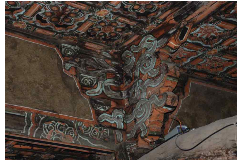
그림 3-36. 청송 대전사 보광전의 동자주 (출처: 문화재청, 『청송 대전사 보광전 정밀실측조사보고서』, 2011, 220쪽)
