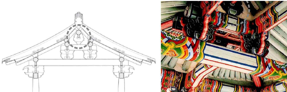
그림 3-40. 평양성 전금문의 대공 (출처: 국립문화재연구소, 『북한문화재해설집Ⅲ』: 일반건축편, 2002, 101쪽)
