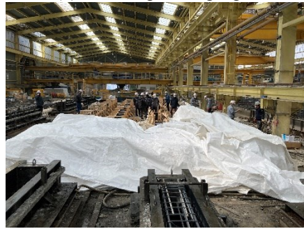
(d) Placing concrete and curing
