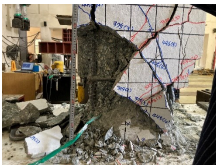
(d) Concrete cover removal after test
