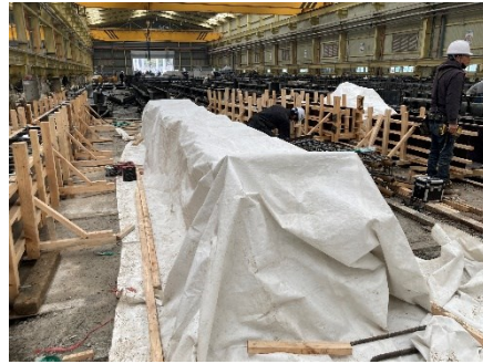
(d) Placing concrete and curing
