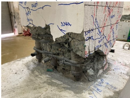
(d) Concrete cover removal after test
