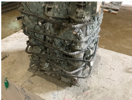
(d) Concrete cover removal after test
