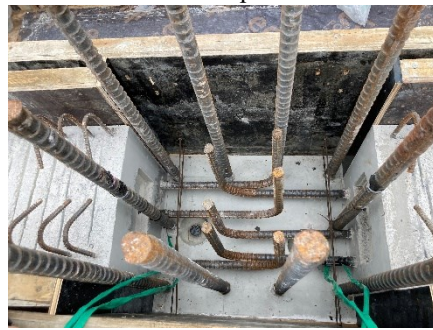
(d) Details of J-G2 inner-joint hooks
