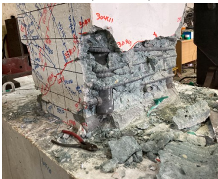
(d) Concrete cover removal after test
