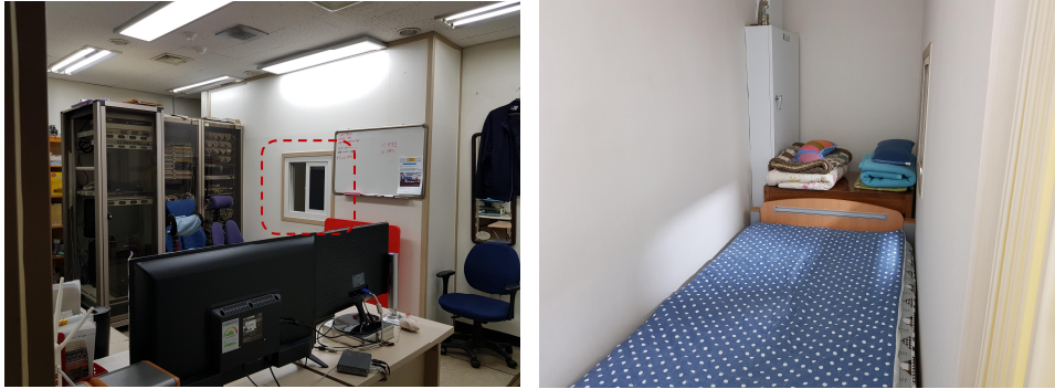
[그림 2-10] A대학 지하 기계실 내 시설관리 노동자의 공간 (출처: 비정규직 없는 A대학 만들기 공동행동, 2019년 자료)
