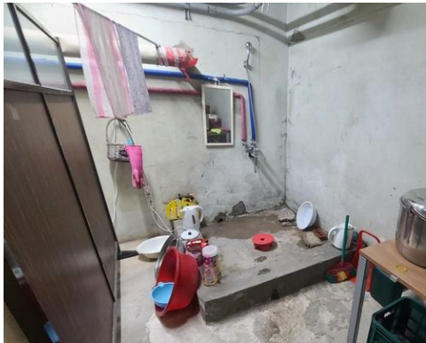
[그림 2-6] 고려대 서울캠퍼스 법학관 구 관 지하에 위치한 세면 시설 (출처: CBS노컷뉴스, 2022.7.18, 임민정)
