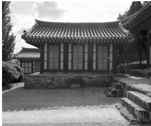
[그림 4-8] 영천향교 대성전의 기단과 석축 152) (출처 : 영천향교 대성전 정밀실측 보고서)
