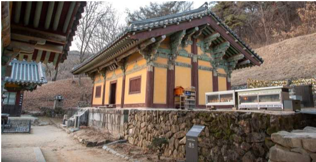
[그림 2-13] 봉정사 극락전에 사용된 기단의 모습 (출처 : 문화재청 홈페이지)
