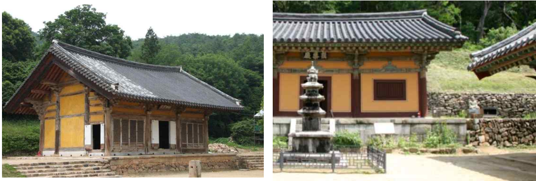
[그림 3-9] 무위사 극락보전과 봉정사 극락전의 기단 입면의 재료가 다른 예 133) (출처 : 문화재청 홈페이지)
