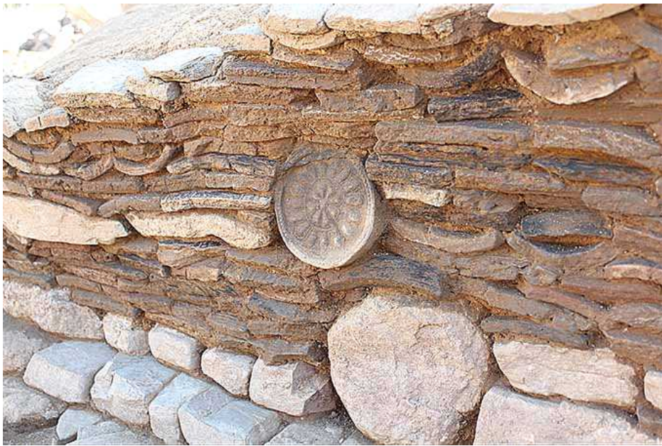
[그림 2-9] 울리 영축사지 금당의 자연석과 기와를 사용한 혼합식 기단 75) (출처 : 울산광역시 문화예술과)
