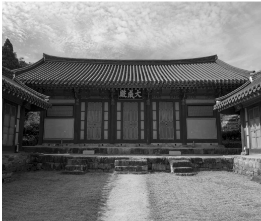
[그림 4-8] 영천향교 대성전의 기단과 석축 152) (출처 : 영천향교 대성전 정밀실측 보고서)
