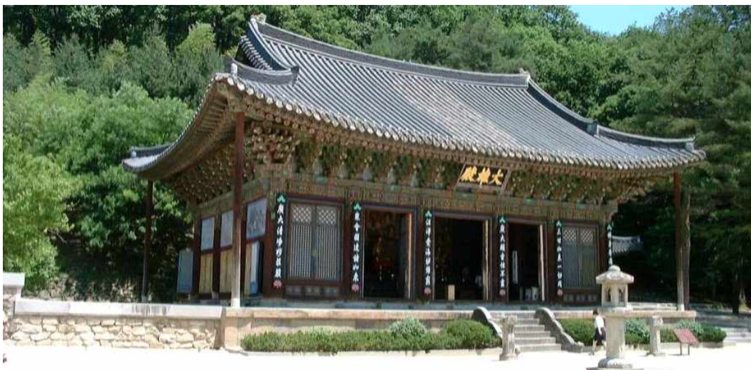
[그림 3-2] 직지사 대웅전의 갑석과 면석으로 구축한 석축형기단의 사례 (출처 : 문화재청 홈페이지)
