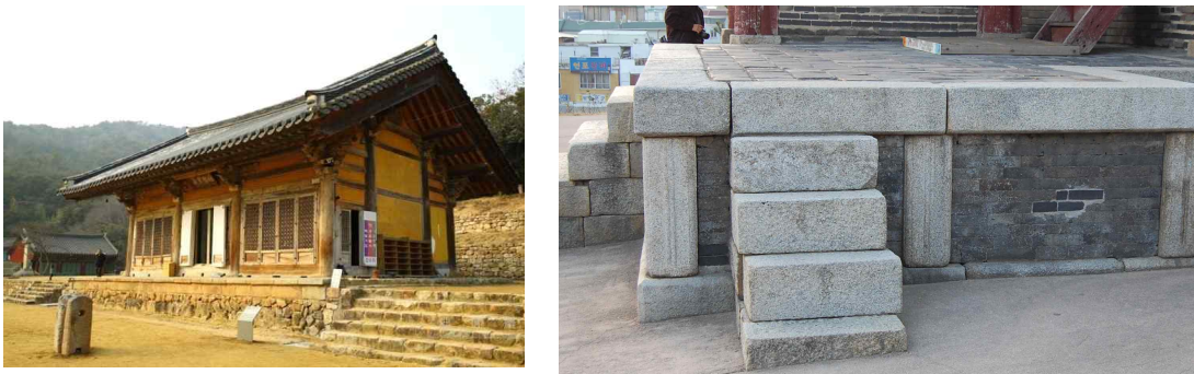
[그림 2-11] 2가지 재료를 사용한 무위사 극락전과 방화수류정 (출처 : 문화재청 홈페이지)
