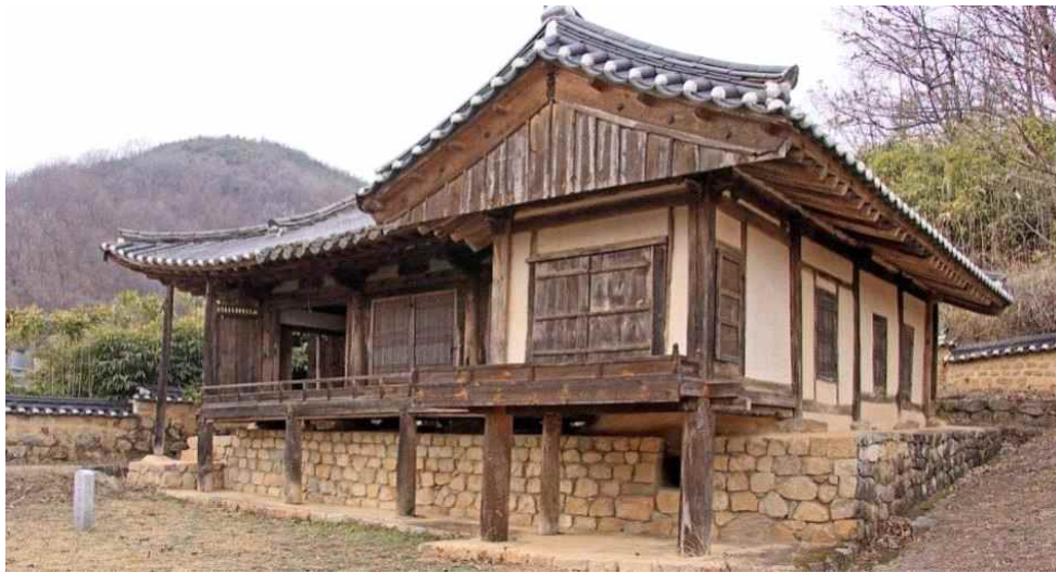
[그림 2-14] 예천 야옹정에 사용된 기단의 모습 (출처 : 문화재청 홈페이지)
