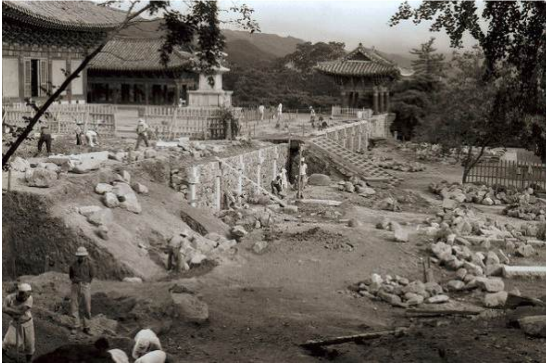
[그림 2-6] 불국사의 기단과 석축의 1974년 복원공사 현장 사진 (출처 : 한양대 박물관 기획전시실)
