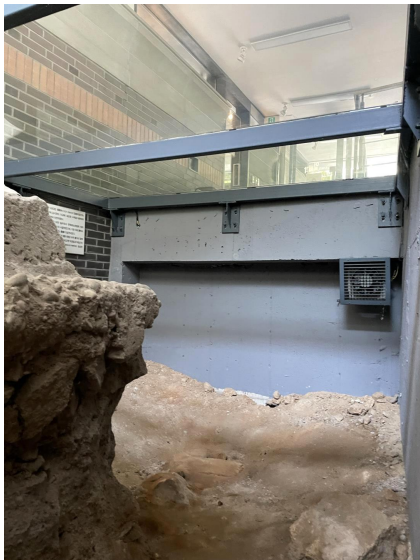
그림 4-29 <일조각> 바닥 유리각 하부 유구와 온습도 조절 장치의 모습
