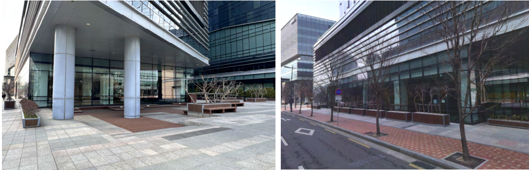
[그림 59] 필로티형 공개공지(좌) / 저층부 돌출형 메스 및 전면부에 설치된 플랜트 박스(우) Source: 직접 촬영
