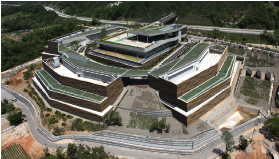
[그림 11] 하이퍼스케일 데이터센터 '네이버 춘천 각', Source: http://www.dmppartners.com/works/detail.html?id=82
