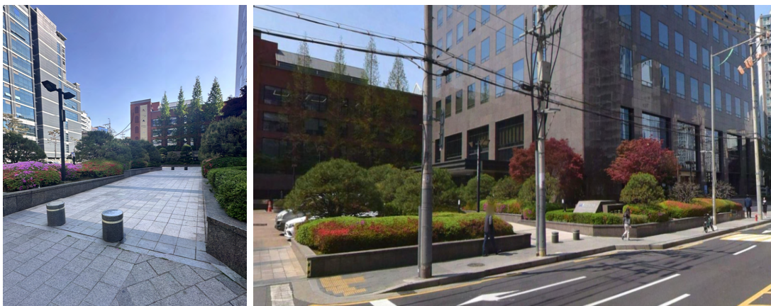
[그림 46] 주출입구변에 위치한 블라드(좌), 높은 화단의 단차(우) (Source: 직접 촬영)
