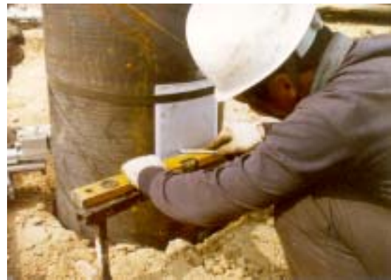
그림 1. 수작업에 의한 항타말뚝 관입량 측정 예
